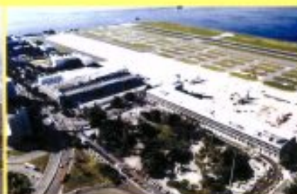
Reforma e adequação do sistema de pátio de estacionamento de aeronaves Refurbishment and adaptation of aircraft concourse
