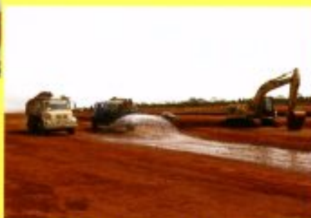
Construção da segunda pista de pouso, paralela à atual com 3.300m de extensão, demais pistas de rolamento e pátios de aeronaves | Construction of second runway, parallel to the existing runway, with length of 3,300m, access runways and aircraft concourses
