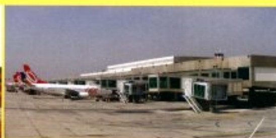
Segunda etapa da reforma e modernização do Terminal de Passageiros, do sistema viário e do sistema de pistas e pátios de aeronaves | Complementary refurbishment and modernization works to the passenger terminal, road system, and runway and aircraft tarmac system.
