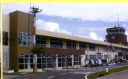
Reforma do antigo Terminal de Passageiros e ampliação da área internacional Refurbishment of old passenger terminal and expansion of the international area
