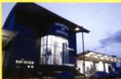
Construção do novo Terminal de Passageiros, Prédio da Administração e Torre de Controle Construction of new passenger terminal, administration building and control tower
